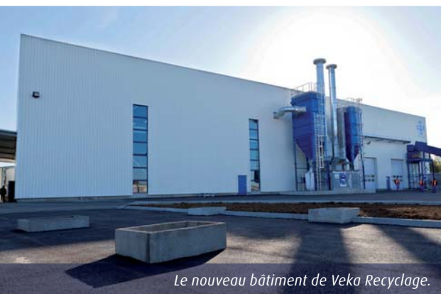
Un système d'aspiration récupère les poussières produites lors du broyage.
