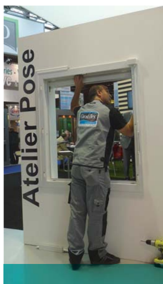
Démonstration de pose d'un VRE par l'intérieur. Grosfillex.
