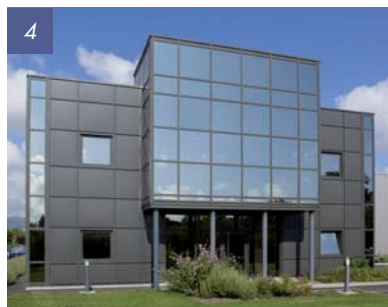
4 - 5 - 6 - Système de façade à serreur Nuance 58 pour grandes dimensions.
