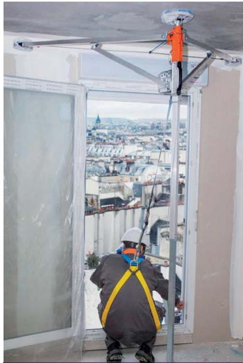
*Le point d'ancrage étant situé au dessus de l'utilisateur, le risque de chute est impossible*
