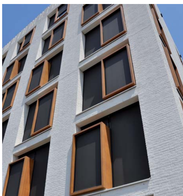
Stores extérieurs à enroulement en Satiné 5500 de Mermet pour la Maison de santé à Nijmegen. © Schellekens-Mermet SAS
