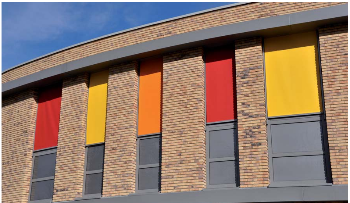
Stores extérieures à enroulement en Satiné 5500 de Mermet à l'école Daltonschool de Leeuwerik à Leiderdorp. © Schellekens-Mermet SAS
