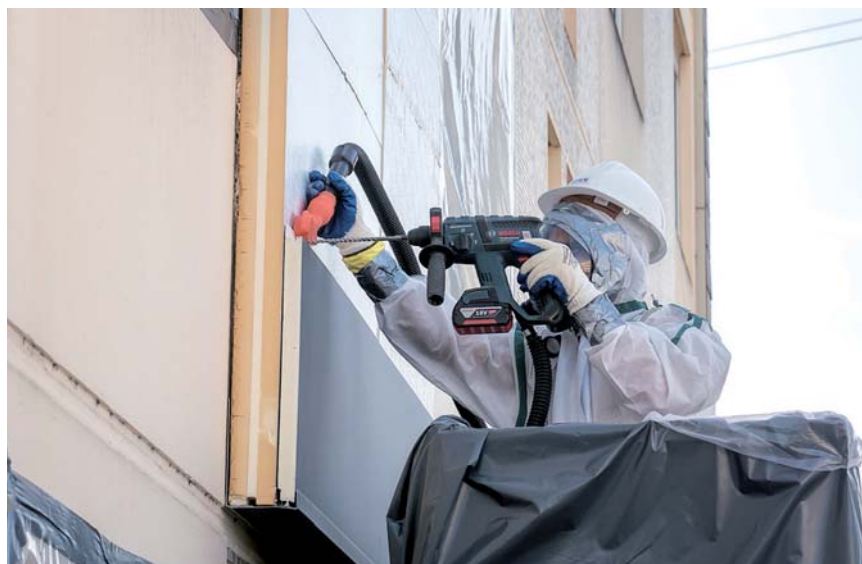
Fixation par collage des profils d'habillage sans contrainte amiante, sans EPI. Myral.
