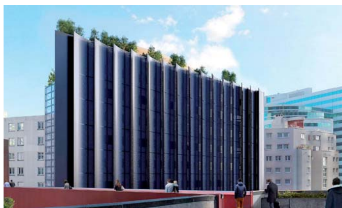
Voiles métalliques ajourées pour protection solaire monumentale. Réhabilitation signée Vincent Eschaliér. ©Vincent Eschaliér
