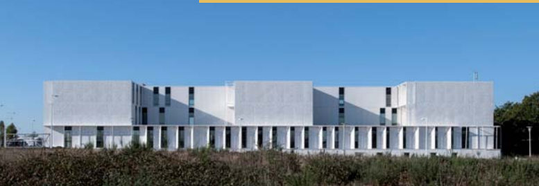
DRISS de Vannes-56. Façade CW50 modifiée par Reynaers pour DDL Architectes à Lorient.
