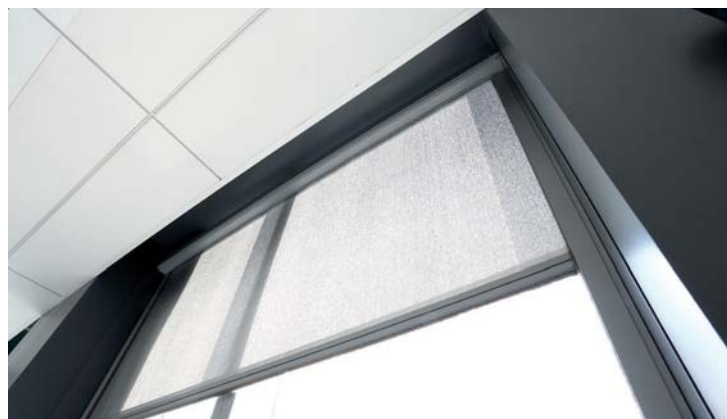
Détail des stores screens automatisés (entre coulisses) en Soltis 99 LowE de Serge Ferrari. © Xavier Mouton-Studio Horizon
