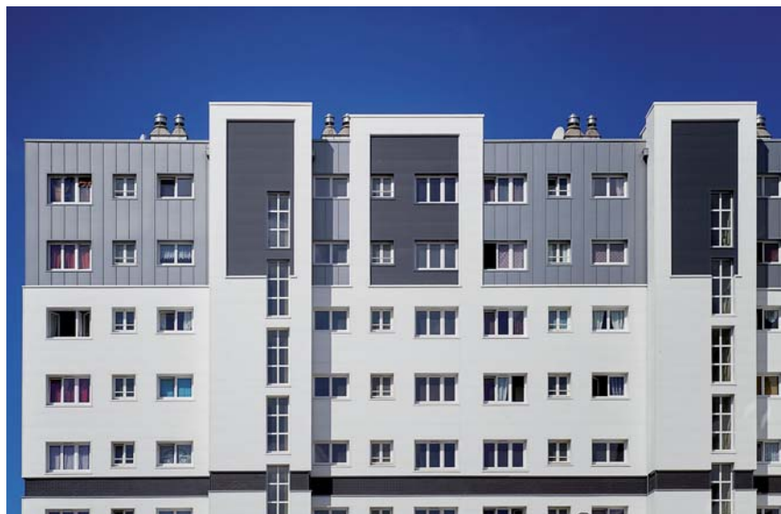
Chantier test à Coudekerque pour le système d'isolation sur façade amiantée de Myral.
