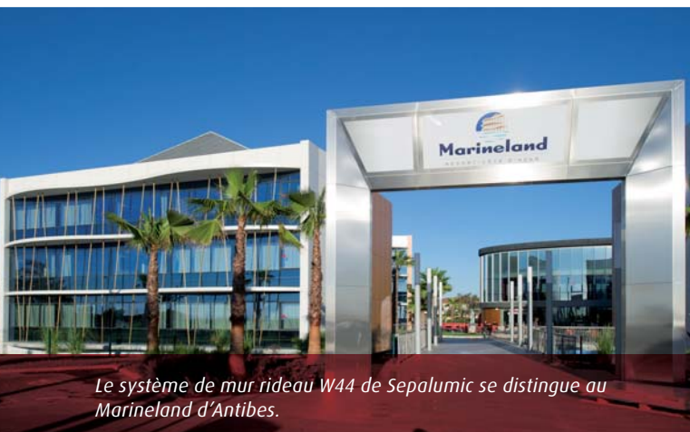
L'architecte du Marineland Resort souhaitait des profils fins, type aile d'avion. Réponse de Sepalumic avec le W44.
