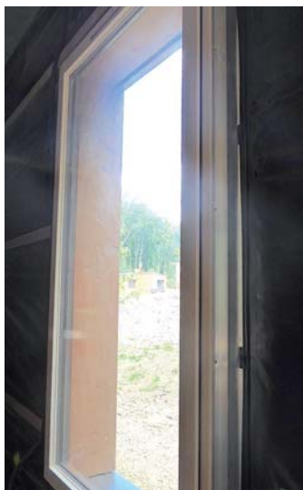
Pose en applique des fenêtres MC France sur cottage Clan.
