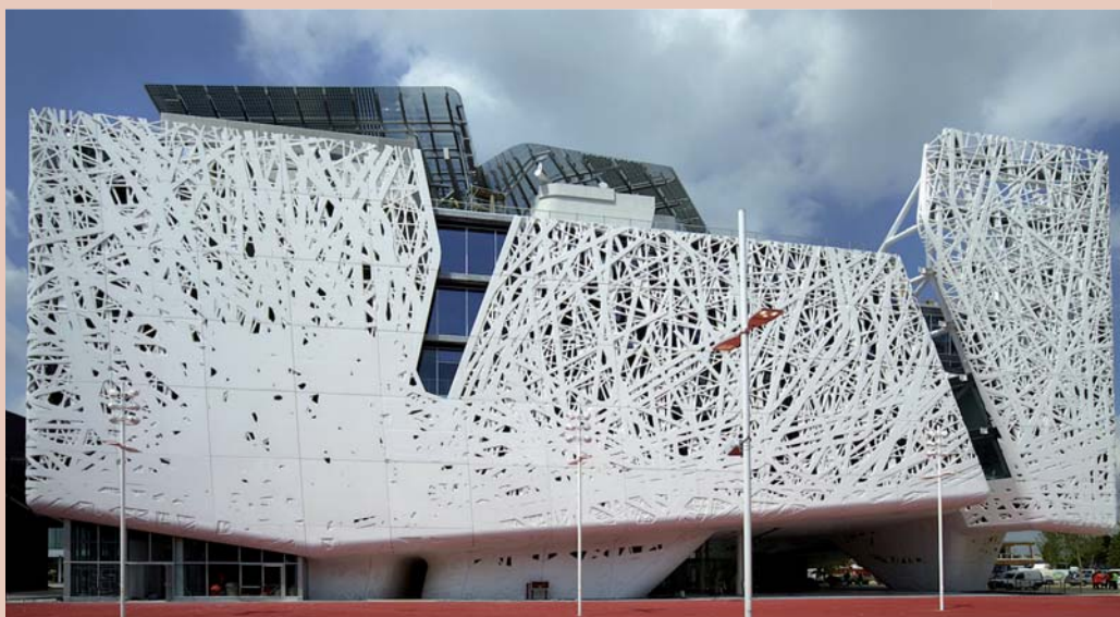
Façade en ciment i.active Biodynamic de Calcia au Pavillon Italien de l'Expo Universelle de Milan.
