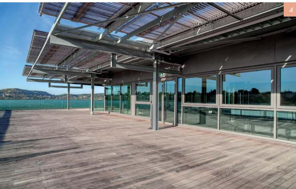
réagir à la lumière, suivant l'incidence du soleil, et qui se marie avec l'arrière-plan - une pinède, d'un vert très foncé toute l'année. » Les tons des menuiseries sont volontairement neutres. Les ossatures du mur rideau sont d'un côté fines et blanches, pour se noyer dans l'aspect de verre opale, et de l'autre côté gris anthracite, se confondant avec les reflets de la pinède.
