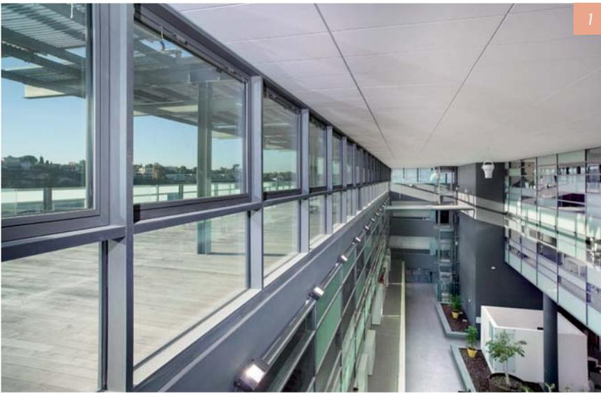
1 - Les tons des menuiseries sont volontairement neutres. Les ossatures du mur rideau sont d'un côté fines et blanches, pour se noyer dans l'aspect de verre opale, et de l'autre côté gris anthracite, se confondant avec les reflets de la pinède.
