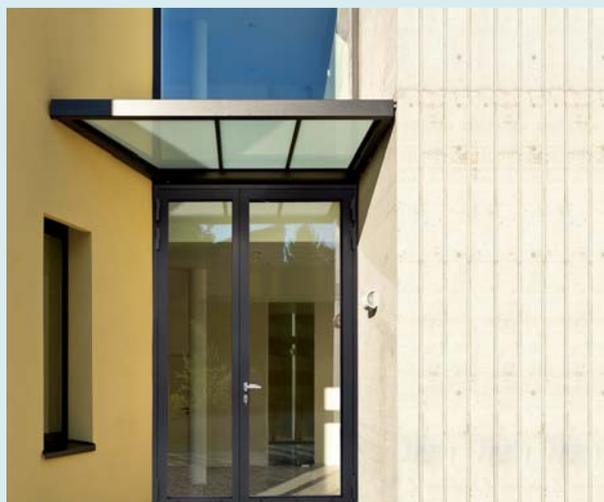
*Système à RPT EI30 sans isolant intérieur de protection feu en application extérieure. VD-Industry.*
