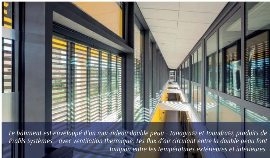
*Le bâtiment est enveloppé d'un mur-rideau double peau - Tanagra® et Toundra®, produits de Profils Systèmes - avec ventilation thermique. Les flux d'air circulant entre la double peau font tampon entre les températures extérieures et intérieures.*
