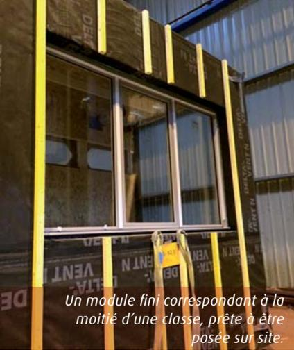
Un module fini correspondant à la moitié d'une classe, prête à être posée sur site.
