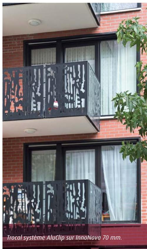
Trocal système AluClip sur InnoNova 70 mm.
