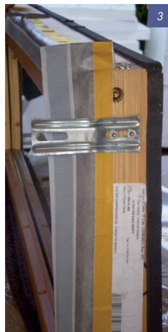
3 - 4 - Détails de pose d'illmod Trio en maison ossature bois. ©Wigwam
