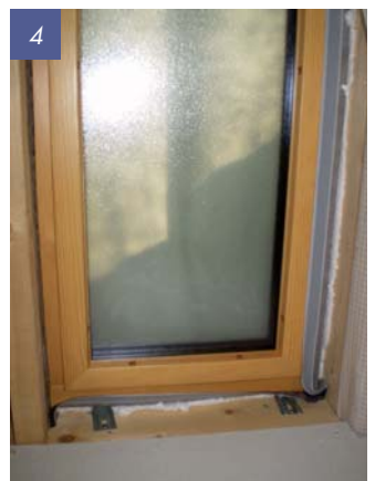
3 - 4 - Détails de pose d'illmod Trio en maison ossature bois. ©Wigwam
