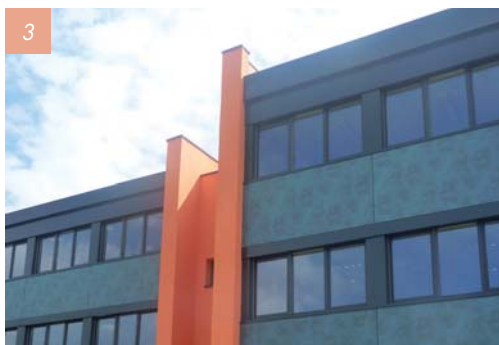
1 - Opération habitat à Courcouronnes (91) : Square de l'Oncle Archibald. © Lorillard
