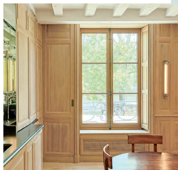
1 - Restauration d'une menuiserie grande hauteur
