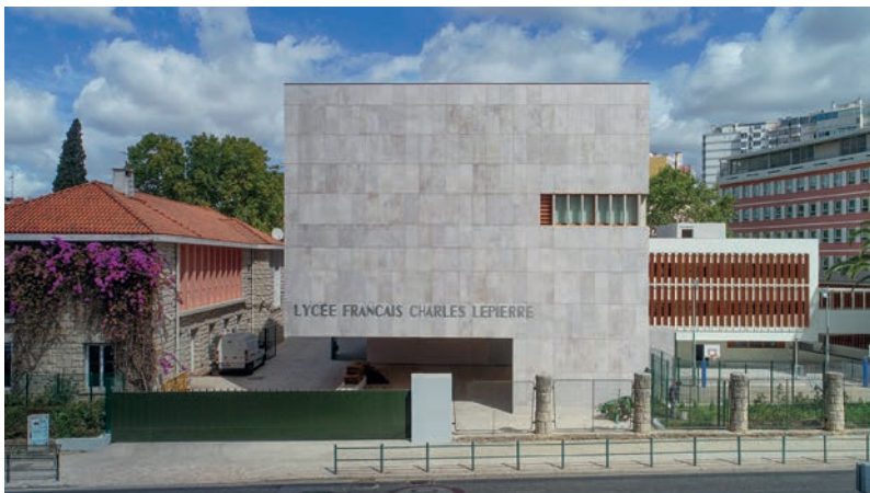
Livrée en 2022 dans la capitale portugaise, l'extension-restructuration de l'école primaire du Lycée français Charles Lepierre de Lisbonne prouve qu'il est possible d'étudier confortablement sous ces latitudes océano-méditerranéennes dans un bâtiment sans climatisation ni VMC, « grâce à une conception bioclimatique frugale alliant paysage et architecture ». Méandre Etc' et Ma.Teriarch architectes associés. © Olivier Wogenscky.
