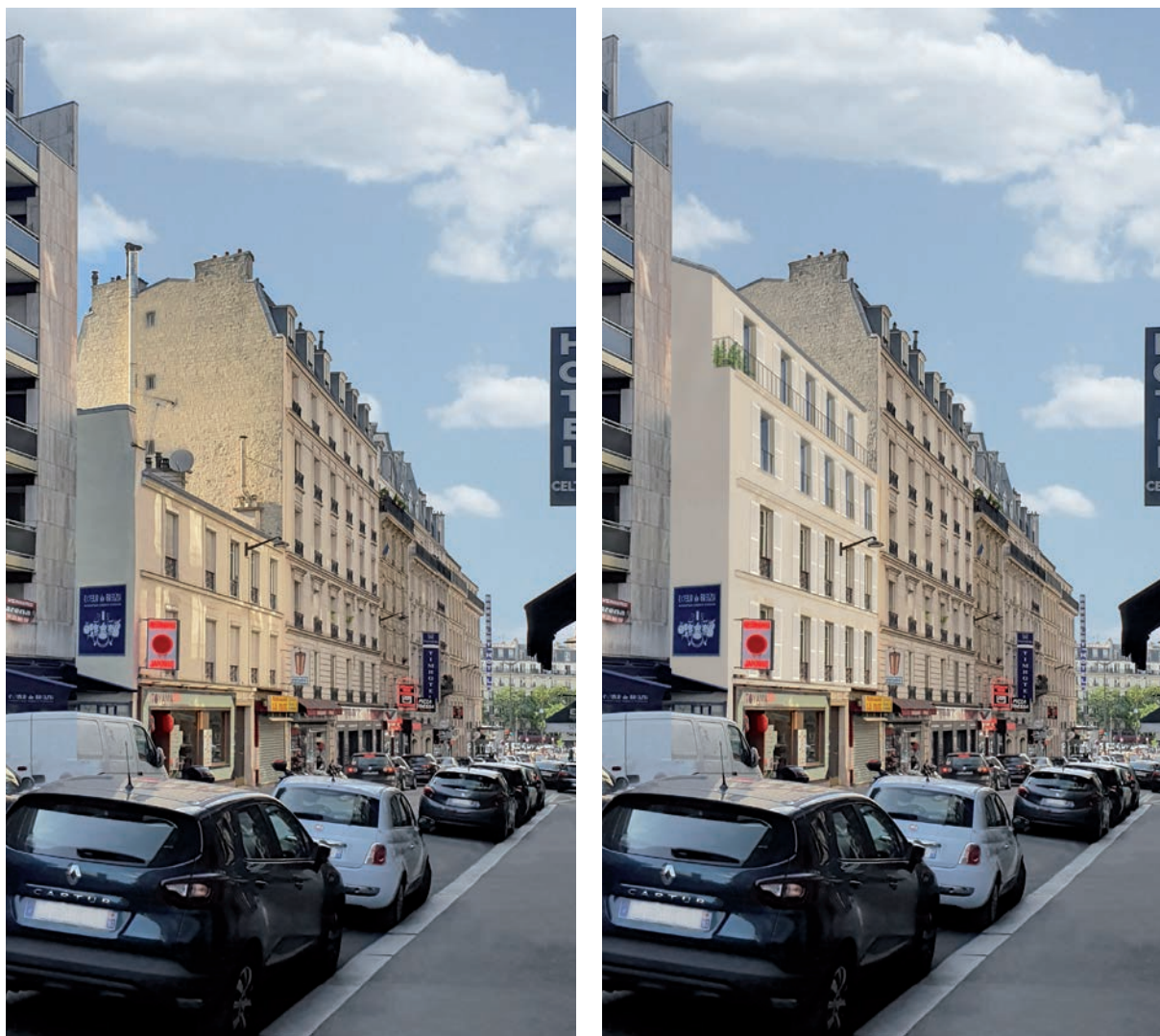
Dans le 14e arrondissement de Paris, le passage du R+2 au R+4 crée 263 m 2 de surface habitable supplémentaires. Les bénéfices pour la copropriété : 470 000 € outre ceux liés à la réhabilitation de l'existant. © Upfactor.
