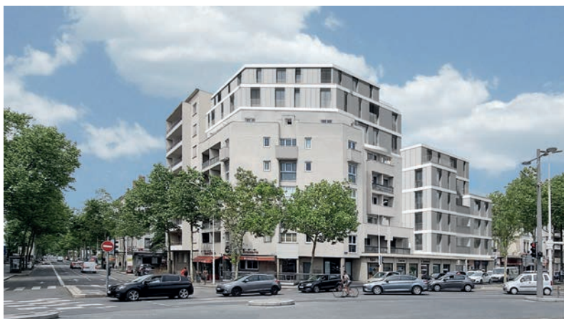
À Lyon, ce projet joue sur les 2 tableaux : création d'un nouveau bâtiment et réhabilitation-surélévation de l'existant avec ITE. © Upfactor.
