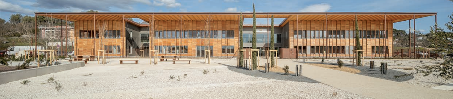
Tout en bois et matériaux biosourcés, l'Espace départemental des solidarités d'Apt témoigne du « fonctionnalisme écologique » selon Apache Architectes. Parmi les dispositifs bioclimatiques : les avancées de toiture sur le pourtour, associées à des brise-soleils orientables et de grandes baies vitrées pour la gestion des apports solaires selon les saisons. Menuiseries aluminium (Schüco). Prix régional de la construction bois en région Sud 2023. ©Photographe : Adria Goula.
