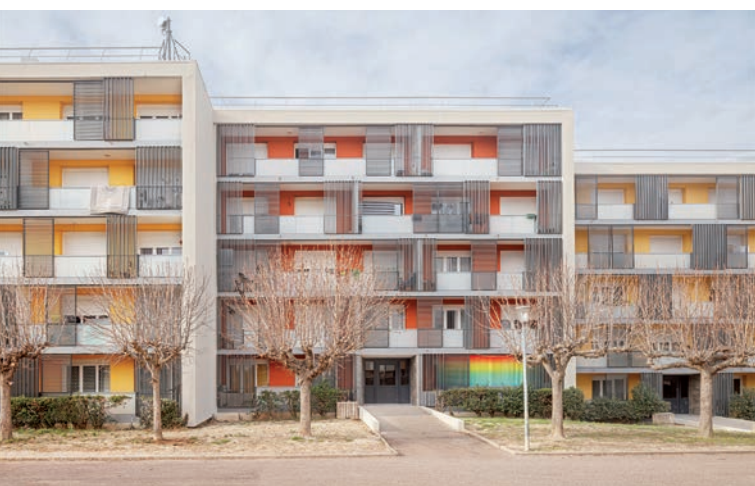
Sur la résidence La Marguerite (Apt, 84), la rénovation des 140 logements sociaux a mis l'accent à la fois sur le confort thermique (via l'ITE et les protections solaires), la qualité d'usage et celle des espaces, grâce à des choix de couleurs et de matériaux passés par la case ABF (Architecte des bâtiments de France). Les volets coulissants sont en aluminium. ©Photographe : Adria Goula.
