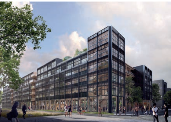
En cours de chantier, la nouvelle résidence étudiante du campus urbain de Paris-Saclay alliera coliving et colocation (150 et 160 chambres). Entourée de bâtiments de bureaux, elle décline une esthétique industrielle dont « les larges baies sur allège pleine facilitent l'habitabilité de la chambre d'étudiant, qui est un espace très contraint, et permettent d'ouvrir sur la nature préservée en îlot du projet ». Menuiseries bois-alu et bardage métallique. ©KOZ architectes
