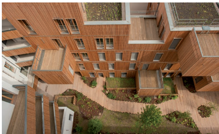
Avec Tête en l'air, KOZ architectes signe pour la SIEMP le premier bâtiment de logements collectifs 100% bois à Paris. Au programme : 30 logements sociaux répartis entre la réhabilitation du bâtiment sur rue, inscrit comme monument historique, et l'extension arrière donnant sur la cour et un généreux jardin. Livré en 2013, « ce projet rendait concret tout ce vers quoi nous tendions depuis une dizaine d'années ! ». ©Pattacini
