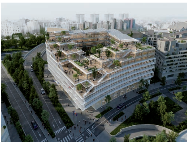
Sur 20 700 m 2 , le futur Pôle rectoral de Créteil (94) s'annonce comme le plus grand bâtiment administratif 100% bois en France. « Le jardin central et le jeu des terrasses en grand, largement vitrés, apportent un maximum de lumière naturelle tout en multipliant les occasions de rencontre entre les métiers et de valoriser l'exposition des travaux initiés par le rectorat dans les établissements scolaires. » Parmi ses labels : E+C- niveau E3C1 et le label Bâtiment Biosourcé Niveau 1. Menuiseries Bois-alu, murs-rideaux en bois. KOZ architectes. ©RSI Studio
