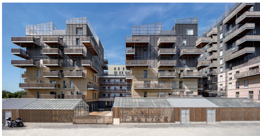
À Strasbourg, Sensations hisse ses 146 appartements sur 38 m. jusqu'à R+11. Livré en 2019, multilabellisé et multiprimé depuis, le plus haut immeuble entièrement bois de France résulte « d'un étroit partenariat entre le maître d'ouvrage (Bouygues Immobilier), KOZ architectes, les entreprises, les bureaux d'études, les bureaux de contrôle, le CSTB, les acteurs de la filière bois et la métropole pour prouver que l'on peut passer à la construction bois en milieu urbain de façon massive ». Menuiseries Bieber. ©Septet
