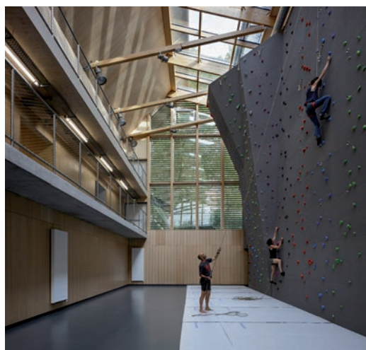
Au cœur du 16e arr. de Paris, L'Atalante « a donné le coup d'envoi de l'aventure olympique en devenant le plus grand gymnase construit intégralement en bois de la capitale. Murs-rideaux en bois et baies XXL ouvrent sur les salles de danse, dojo, mur d'escalade, terrain de foot, terrain de tennis depuis le Bois de Boulogne et l'avenue Maréchal d'Espèrey ». ©Septet
