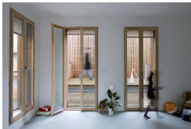
Sur Tête en l'air, « les ouvertures sur cour, plein sud, sont des menuiseries bois triple vitrage étroites et hautes pour à la fois se lier à l'existant du bâtiment réhabilité et s'inscrire dans l'économie du chantier en s'intégrant dans la trame de l'ossature bois. Leur nombre, jusqu'à 3 ou 4 par pièce, permettent de proposer des espaces intérieurs lumineux ». KOZ architectes. ©Septet
