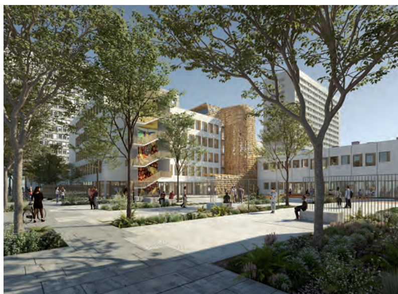
En cours, la transformation du lycée Jean Quarré en médiathèque et la construction d'une maison des réfugiés. En terre coulée et ossature bois, un projet d'écoconception exemplaire au cœur de Paris (19e arr.). Maître d'ouvrage : Ville de Paris. Architecte mandataire : Atelier Philippe Madec, architecte associé : Nicolas Miessner.
