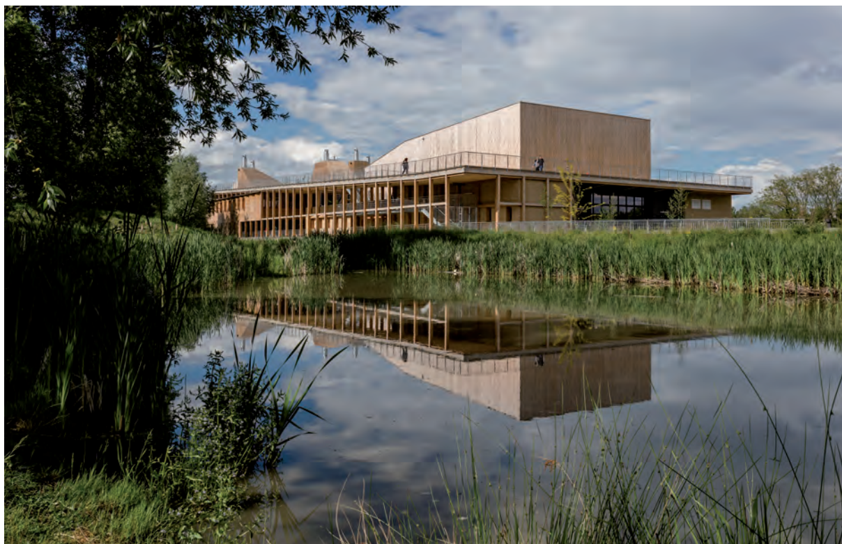
Multiprimé, le pôle culturel de Cornebarrieu (31) : un bâtiment bois et terre de niveau passif. © Pierre-Yves BRUNAUD / Picturetank.
