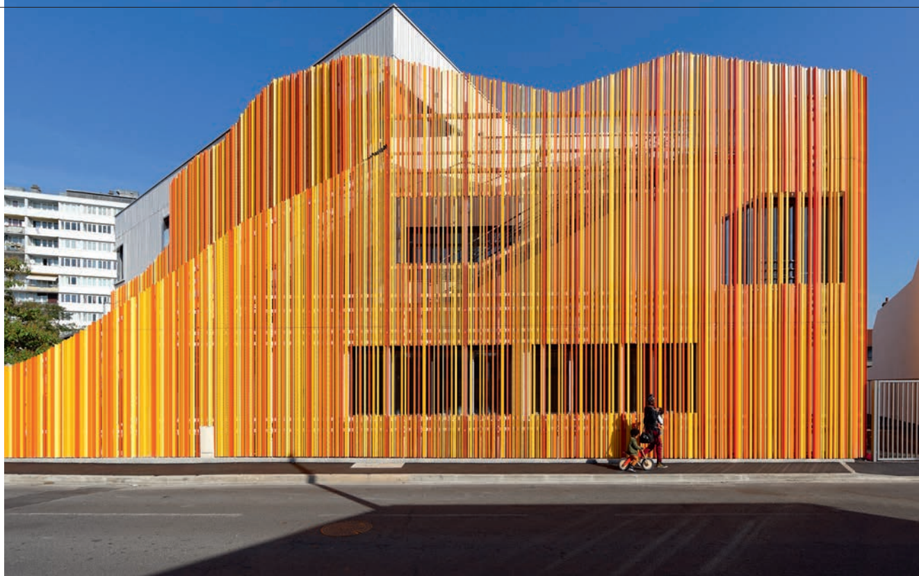
À Ivry-sur-Seine, le groupe scolaire Makarenko. Une peau en bardage aluminium aux couleurs des protections solaires enveloppe l'ensemble créé par la rénovation de l'existant et la construction d'un nouveau bâtiment. Un repère renouvelé pour les habitants de la cité, impliqués dans la conception de l'espace public qui en marque l'entrée. AIR Architectures. ©Photo : David Bourreau.
