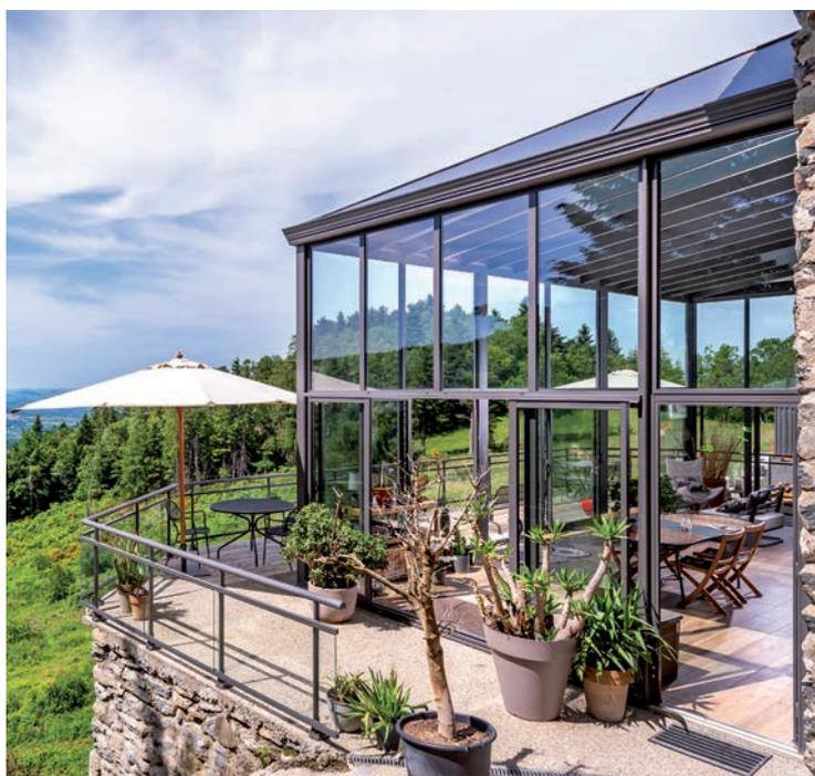
Les trois coulisants Galaxie 32 TH deux vantaux, la porte d'entrée Comète 70 TH, et un coulisant deux vantaux, tous à rupture de pont thermique, contribuent à l'étanchéité et l'isolation de cette pièce exposée plein sud.
