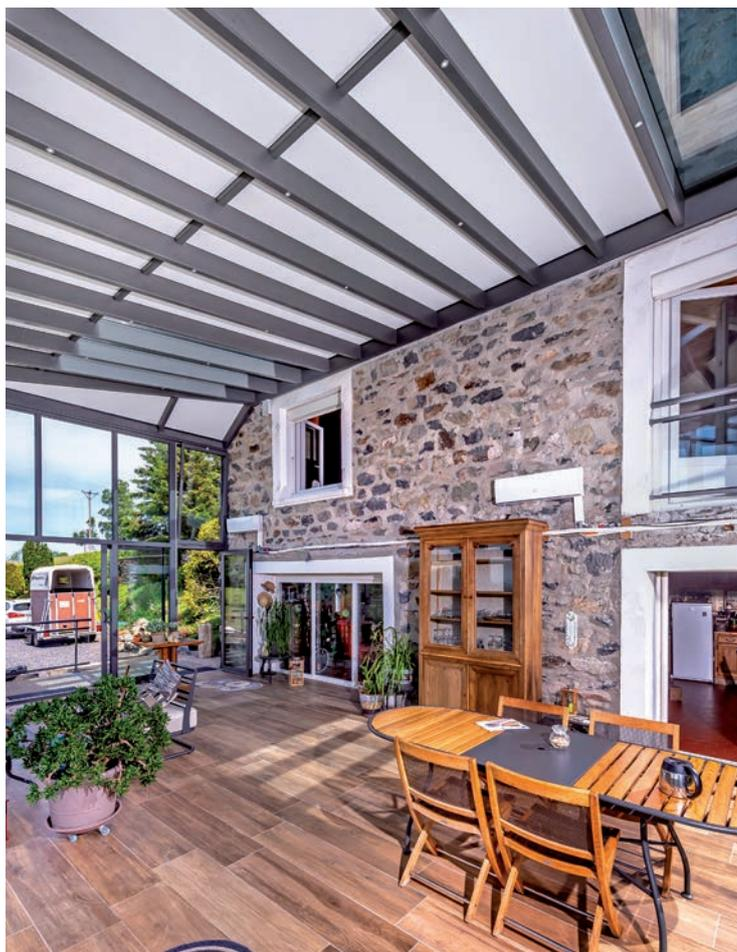
La toiture tubulaire de la véranda Luciole d'Installux se compose de panneaux de remplissage et d'un puits de lumière de trois panneaux vitrés de 68 mm.
