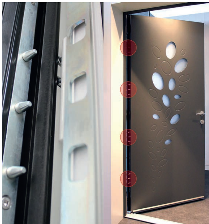
Avec Eurastop, Euradif dote sa porte d'entrée Passage d'une barre 12 pions anti-dégondage. Une exclusivité pour sa porte monobloc en aluminium.
