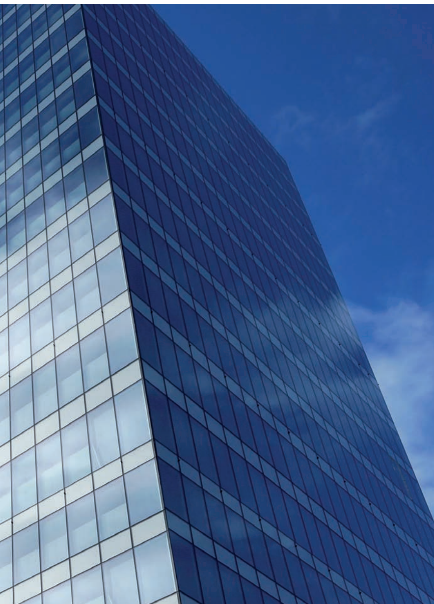
Une nouvelle façade adaptée aux IGH. © Cortizo.
