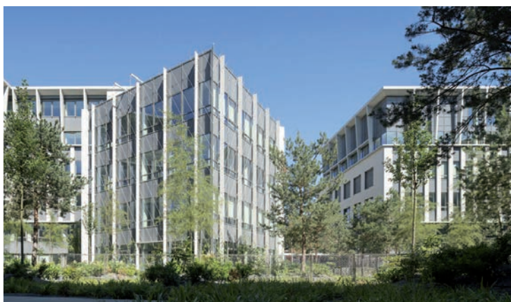
Reynaers Aluminium a créé 4 profils pour ce projet portant sur 9000 m 2 de façades. © Photo : Nicolas Borel.
