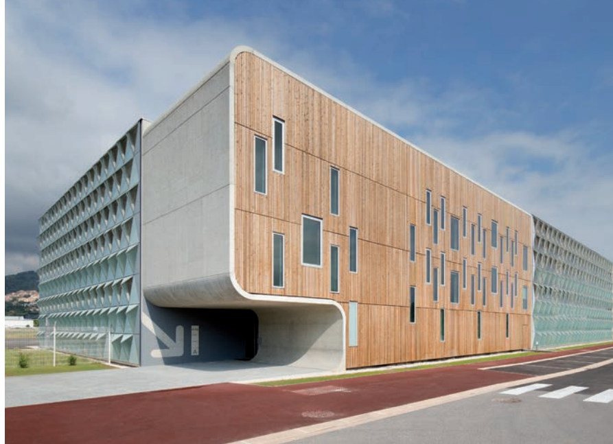
Les façades de l'aéroport de Cannes Mandelieu constituent un exemple de créations spécifiques signées Kawneer. Comte et Vollenweider Architectes. © Photo : Xavier Boymond.
