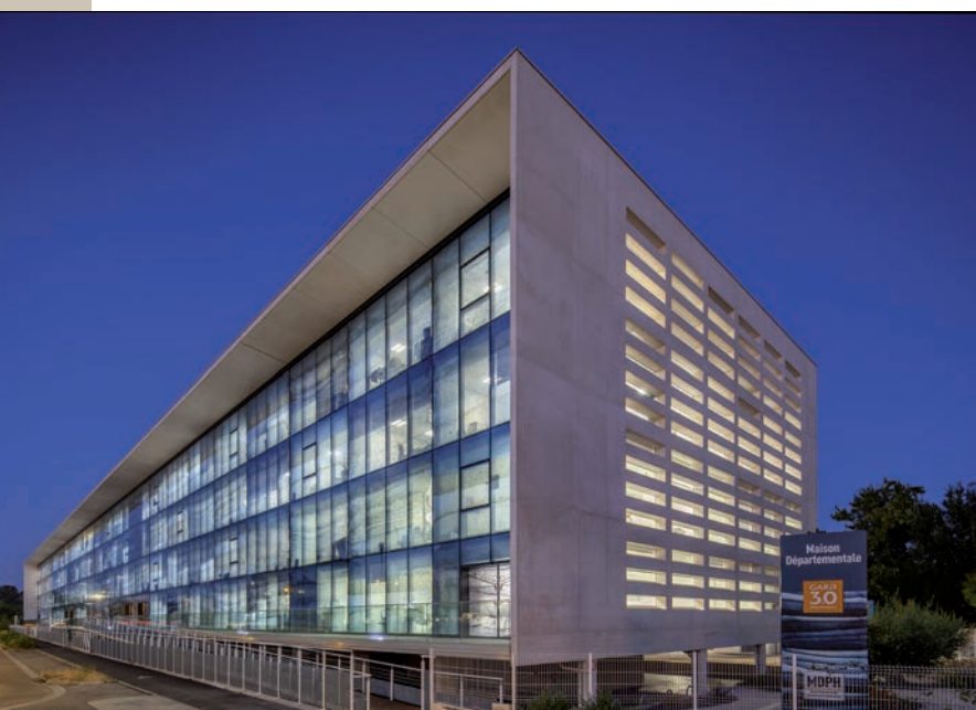
Profils Systèmes a développé une version VEC de la façade Tanagra, ici sur le bâtiment PGB signé Rudy Ricciotti. © Photo : Richard Sprang.
