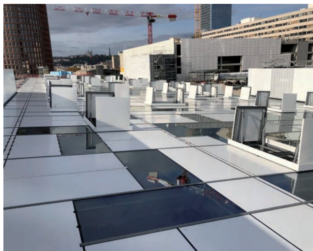
Le panneau Sky Fill équipe la nouvelle verrière du centre commercial de la Part-Dieu, à Lyon. Maître d'ouvrage : Unibail-Rodamco. Architecte : MVRDV. Façadier : Coveris. © Isosta.
