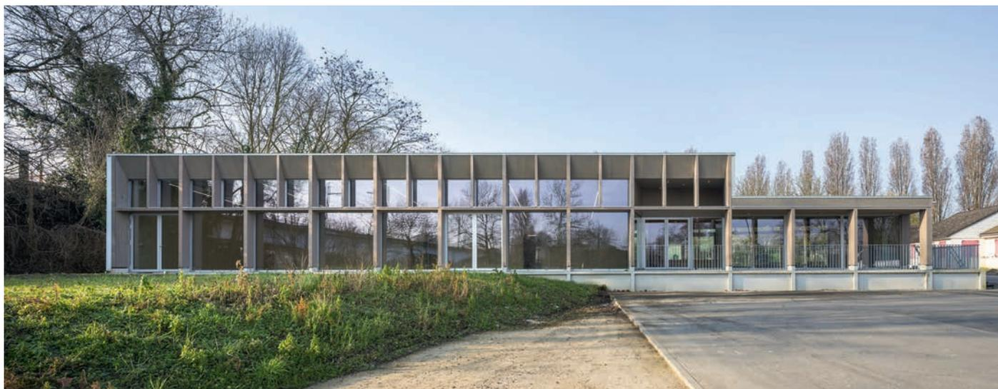
*L'extension du Centre de loisirs La Prairie, à Choisy-le-Roi : la structure en ossature et charpente bois permet une exécution rapide, un chantier à faible nuisance et un bâtiment bas carbone. Châssis aluminium Technal. Oyapock architectes. Livraison 2021. ©Photo : Sergio Grazia.*
