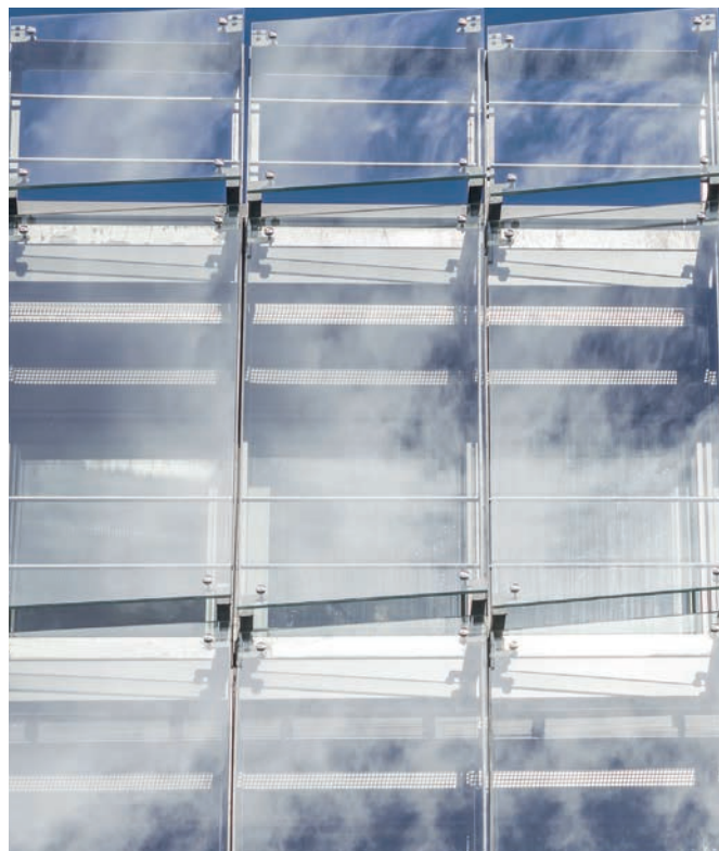
Le mur rideau en double peau ventilée Ouest Alu scintille sous 192 écailles vitrées convexes et inclinées, agrafées à la structure. © Photo : Kamel Khalfi.
