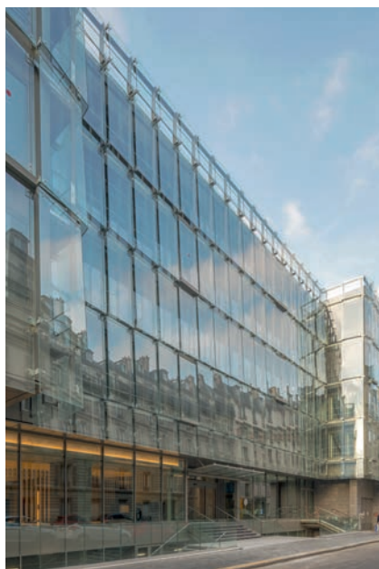
Le mur rideau double peau épouse le renforcement de la façade principale sur rue.
