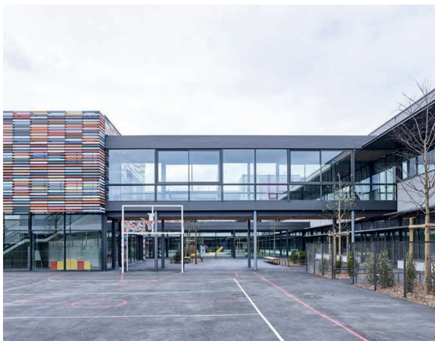
La vêtue en bardeaux de terre cuite, expérimentation en référence à la culture de la région, alterne des teintes naturelles mates et des émaillés colorés.
