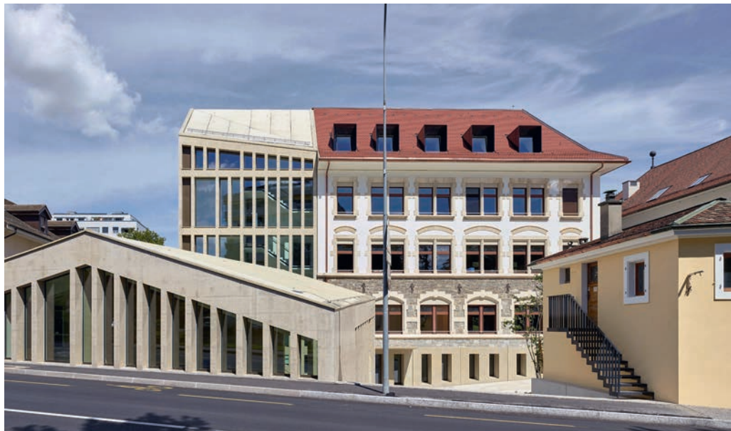
Sur l'ancienne préfecture de Versoix, les châssis bois-aluminium disparaissent dans l'épaisseur du béton. Architecte : Cathrin Trebeljahr. © Photo : Thomas Jantscher.
