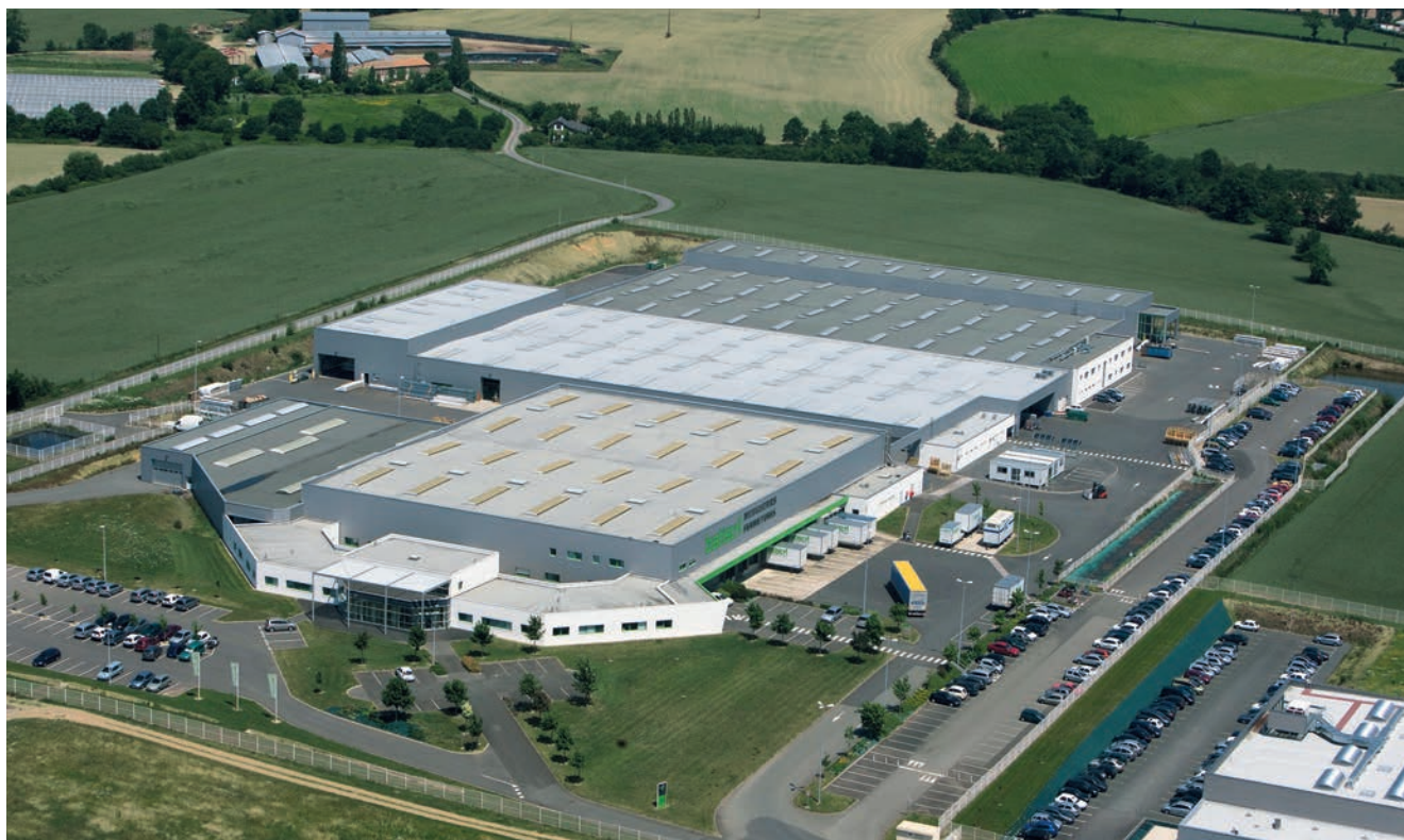
Le siège social et le site de production du Groupe Batistyl situé à Maulévrier (49).
