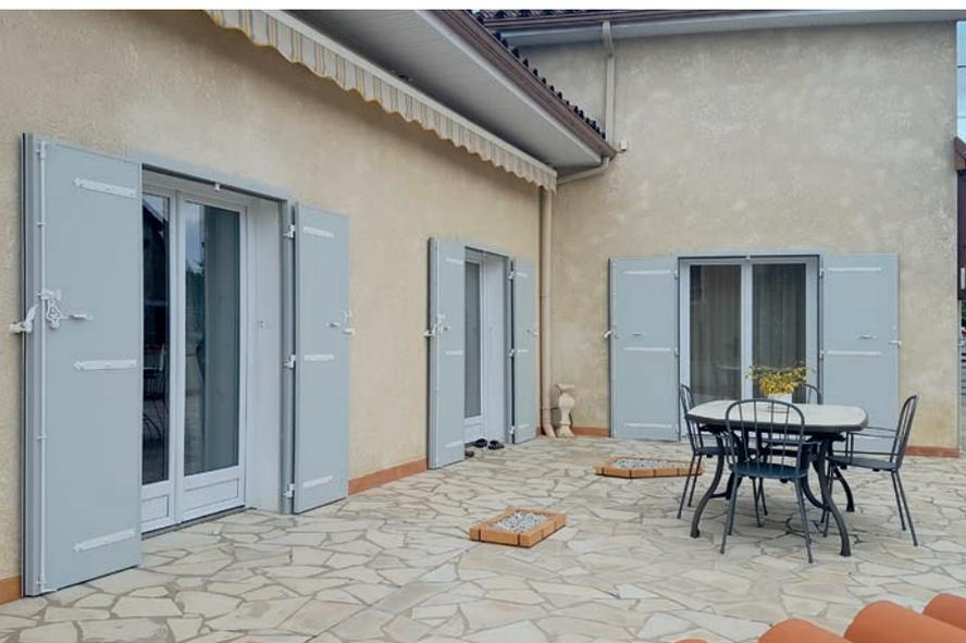
En neuf, le pré-cadre de volets battants de **Maine Clôtures** évite de sceller des gonds dans la maçonnerie. En rénovation, il masque les irrégularités autour des fenêtres comme les traces des anciens gonds. Avec leur joint de calfeutrement dans le pré-cadre, les profilés en aluminium extrudé laqué en forme de "L" augmentent l'occultation des volets. Le large éventail de couleurs possibles assure une fabrication en fonction des teintes des volets, des menuiseries ou de la façade.
