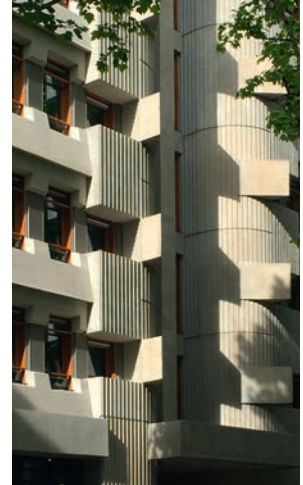
Les décrochés des quelque 700 nouvelles menuiseries bois dessinent des jeux de reliefs nouveaux en écho à ceux du béton. © Photo : Pierre L'Excellent.
