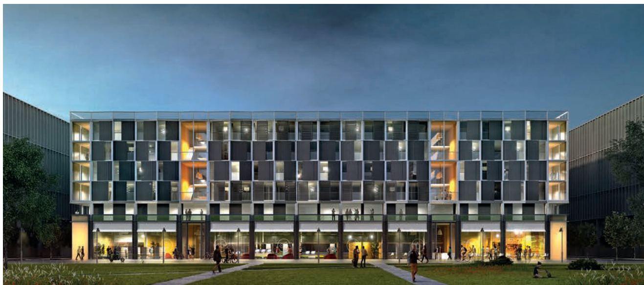
La future résidence étudiante C22B sur la ZAC Polytechnique du plateau de Saclay. Derrière la générosité des ouvertures en façade, neuf typologies distinctes de logements. © Photo : Maciej Józefiak.
