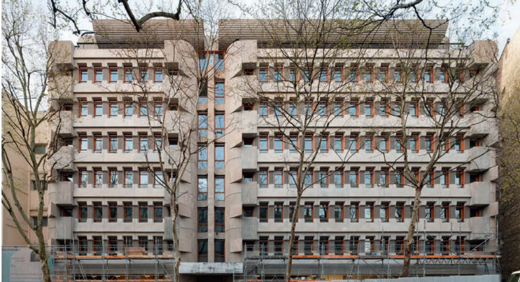
La réhabilitation par Canal Architecture des anciens bureaux des 58-66 rue Mouzaïa (Paris XIXe) permet la création de 288 logements répartis entre résidence étudiant-jeunes travailleurs, ateliers d'artistes et centre d'hébergement, outre des espaces de bureaux et de co-working. Ici la façade du 58 (2019). © Photo : Pierre L'Excellent.
