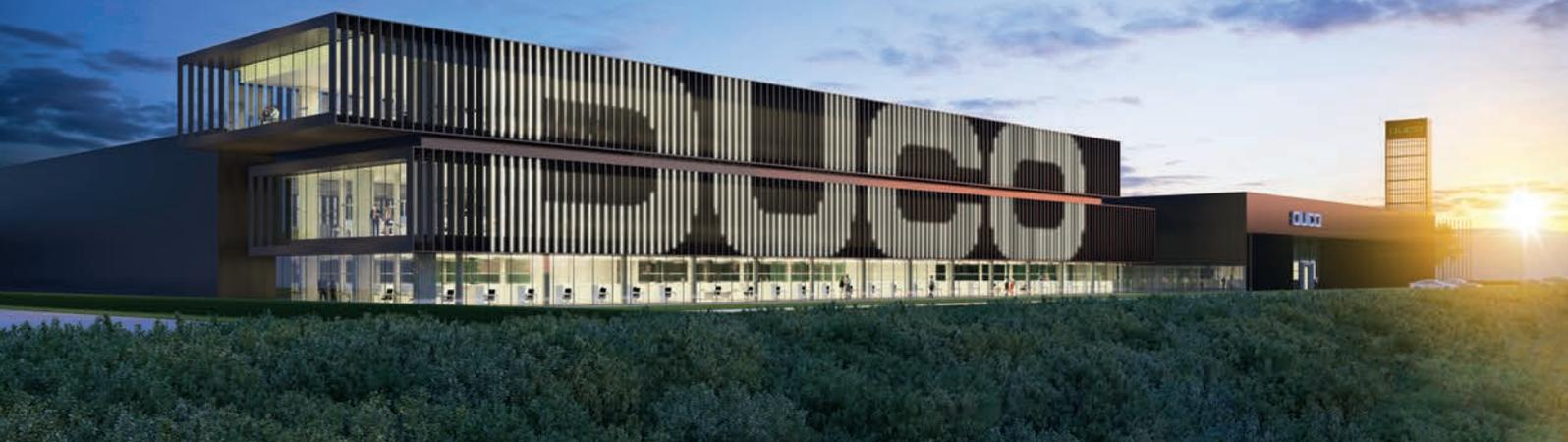
*DucoSun Cubic Design déploie de très grandes lames brise-soleil (400-500-600 mm), subtilement rainurées, pouvant intégrer des LED sur tout ou partie de la tranche de la lame.*
