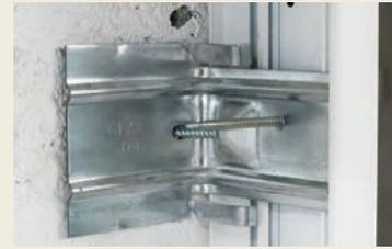
**Louineau étoffe son offre de dépose totale.** Le pionnier des pattes de rénovation en dépose totale (PRDT) enrichit son offre avec une solution globale conforme au DTU 36.5. Elle inclut une patte renforcée (BTRDT), une cornière filante (CFILRDT) et un guide de perçage. Valable pour tout type de supports constructifs et les menuiseries de tout matériau, elle s'adapte à tous les chantiers (de 60 à 200 mm d'épaisseur d'isolation).
