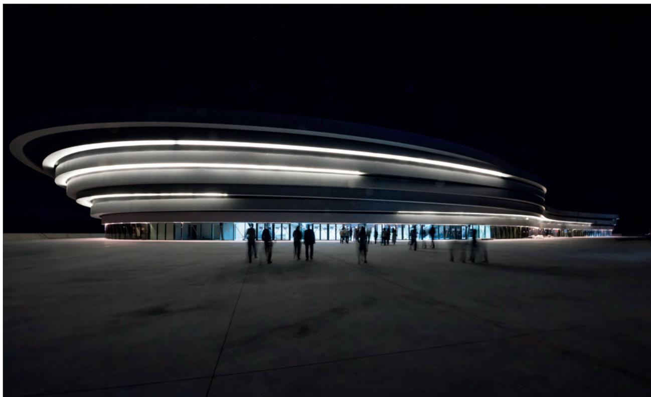
L'Arena d'Aix-en-Provence lévite sur son socle en vitré conçu à partir de mur-rideau Tanagra et de profils spécifiques.
