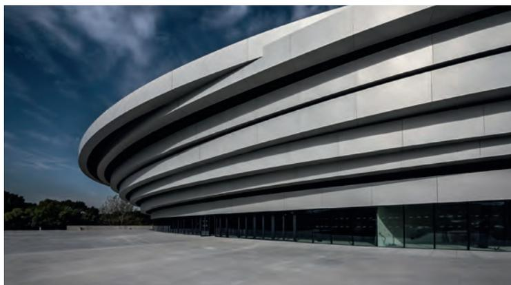
*Arena d'Aix-en-Provence : transparence maximale grâce aux modules encastrés (L. 1,30 m x H. 2,30 m), disposés en facettes pour former un périmètre de 444 m.*
