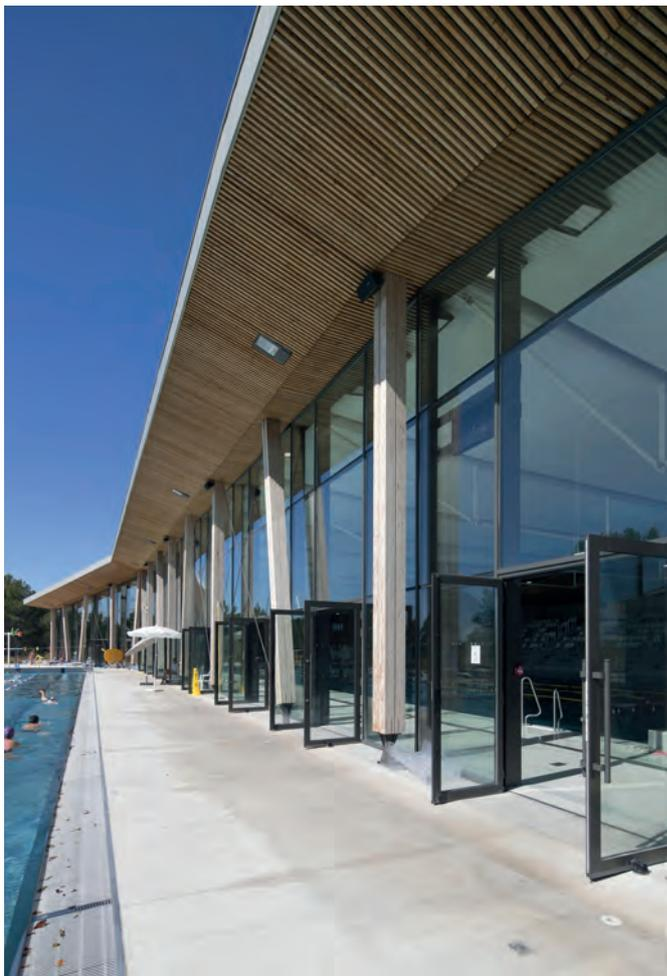
particularité est de se vitrer par dévêtissement, ce qui induit une technique de fabrication et une technique de vitrage (en portefeuille) aisées dans l'atelier et sur chantier, les châssis pouvant être vitrés avant ou après la pose. Profils à RPT compatibles avec les châssis Kawneer en 52 et 72 mm, vue d'aluminium réduite de 50 mm, prise de vitrage 24 à 28 mm, système réversible parclosage possible en intérieur...
