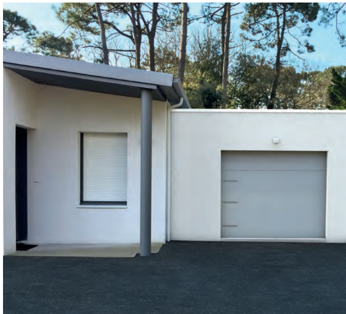
Le bâti aluminium sur lequel sont prémontés de nombreux éléments d'Illiade de Sothoform améliore sa rapidité de pose.
