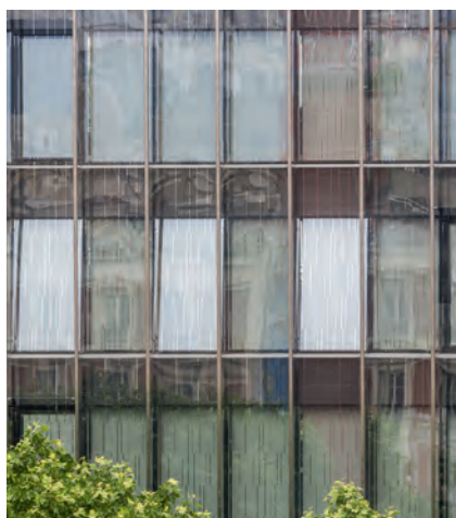
Derrière les vitrages sérigraphiés, plus de 500 stores enrouleurs contribuent aux performances du bâtiment labellisé E+C-. ©Bandalux.
