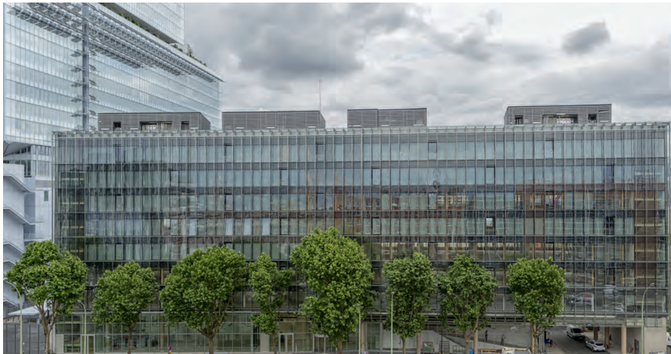
Le Thémis, 80 mètres de façades vitrées au pied du nouveau Tribunal de Paris. ©Bandalux.
