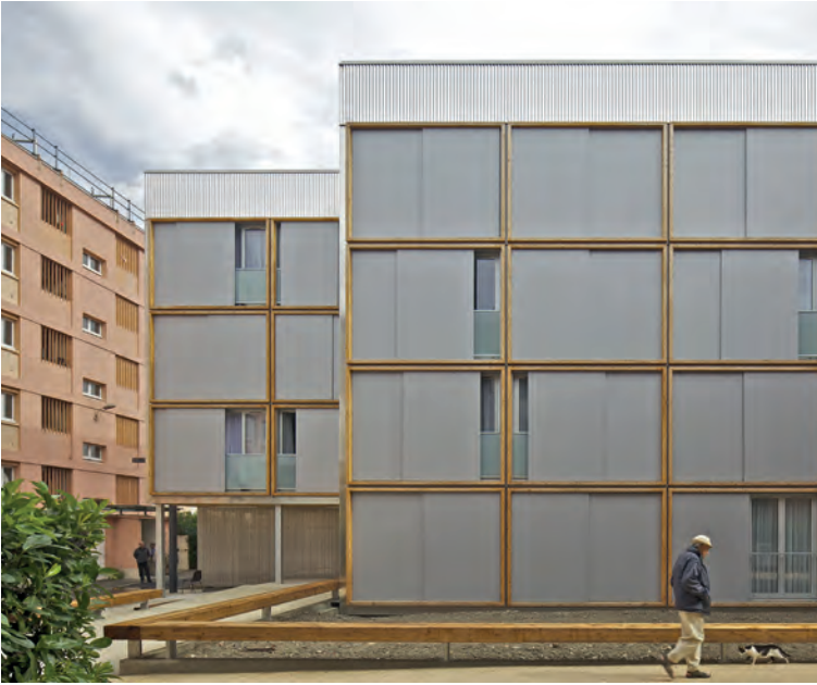
Les 50 logements sociaux T1 et T1 bis de la résidence ADOMA (MOA) à Toulouse (2015), ou comment innover au service de l'insertion et de la qualité de vie. Construction modulaire bois (CLT), bardage en tôle ondulée aluminium, fenêtres aluminium double vitrage et volets coulissants aluminium sur cadre métallique. Photos © Philippe Ruault.
