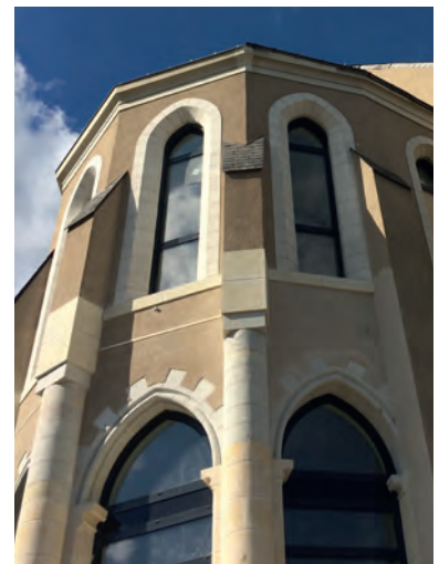
Une réalisation majestueuse : la réhabilitation de la chapelle d'Angers
