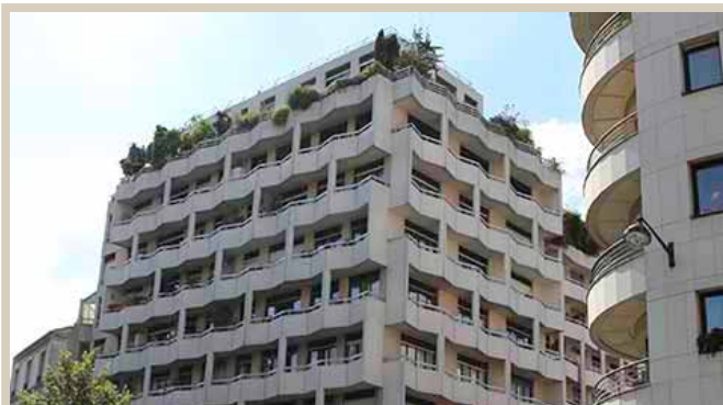
171 fenêtres TROCAL 76 ADVANCED pour cette rénovation à Paris.
