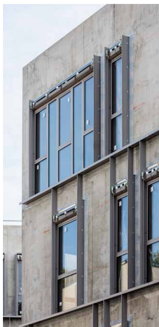
Immeuble de bureaux Oxaya à Lyon, premier chantier 100% BIM de Sapa avec l'adaptation de l'ouvrant visible Performance 70FP. Maître d'ouvrage : Icade. Axanadu Architectes et Urbanistes.
