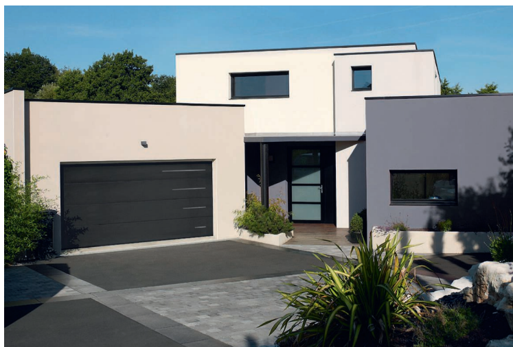
Grâce à la box domotique Tydom, la porte de garage Novoferm s'actionne individuellement ou simultanément avec d'autres éléments de la maison.
