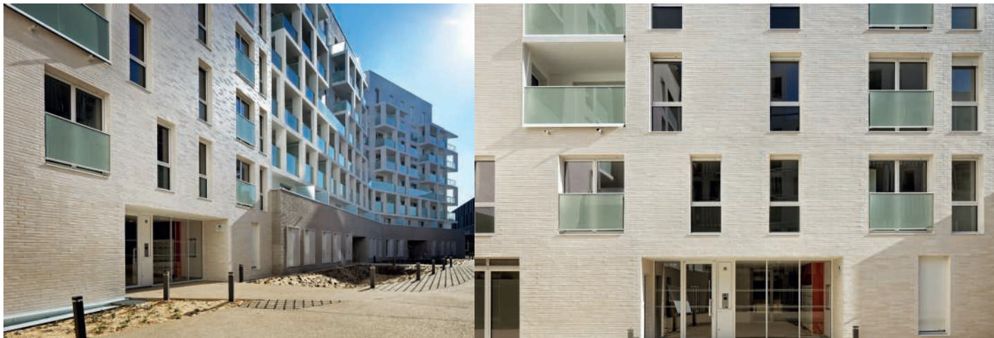
À Ivry Confluences, baies, balcons et loggias participent du relief affirmé des façades en brique blanche. Menuiseries Bois-Alu . 84 logements sociaux, 39 en accession. Maîtrise d'ouvrage : Cogedim et Sodearif, bailleur social : Immobilière 3F (2015-2016). © SAA Architectes.
