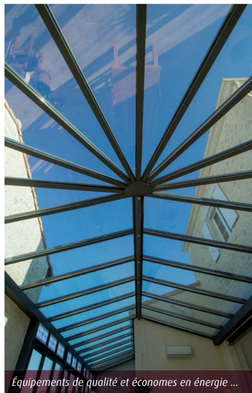
1 - 2 - Si la collection Éléganz proposée par Véranda Rideau offre le charme d'un style Victorien, elle ne sacrifie pas au confort moderne grâce à des profils en aluminium à rupture de pont thermique, et de double vitrage à isolation thermique.
