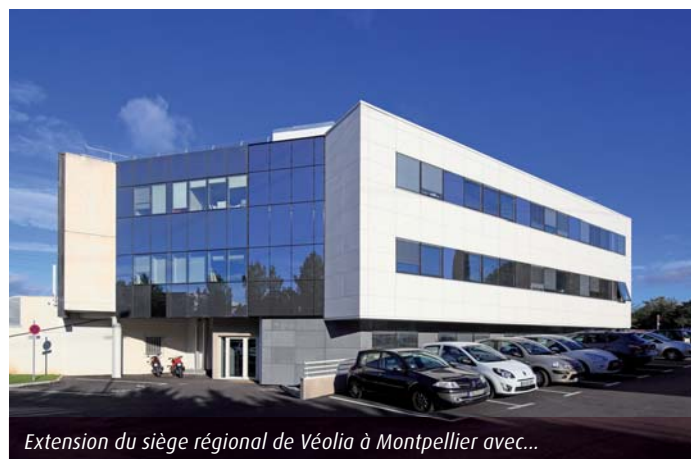
...mur rideau Mecano VEC et stores intégrés à fenêtres respirantes Wicona.
