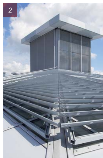
1 - 2 - Brise soleil Icarus® de Renson, sur le nouveau siège d'Adeo.
