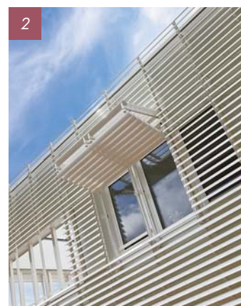
1 - 2 - Protection solaire dynamique Cilium de Renson® sur le nouveau Palais des congrès de Saint Brieuc
