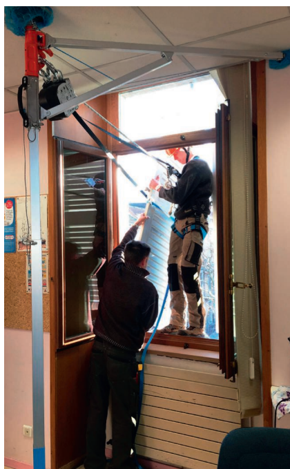
Lors de la dépose d'un volet battant, le SYAM permet de sécuriser aussi bien l'opérateur que le volet (évitant qu'il ne tombe en contrebas). © SYAM
